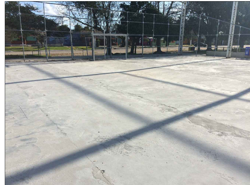
03.PISO QUADRA A RECEBER NOVA CAMADA DE CONCRETO DE 5 CM DE ESPESSURA E PINTURA PARA QUADRA
